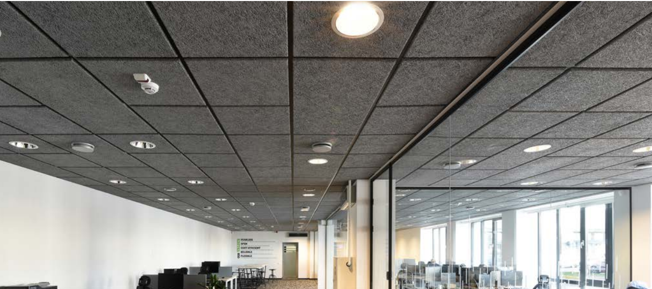
Moldura em perfil tipo T, perfil de bordo P0G, painel acústico CEWOOD de 25 mm.
