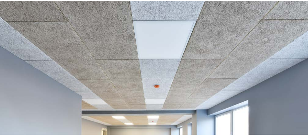
Estrutura metálica em perfil CD, perfil de bordo P5, painel acústico CEWOOD de 25 mm.
